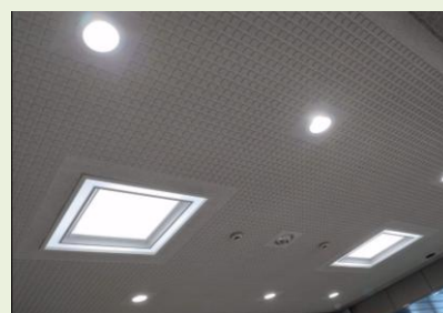
LED 照明の入れ替え
